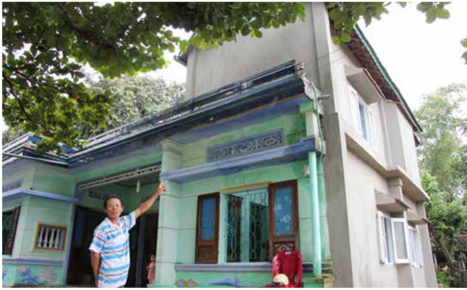
Ông Nguyễn Lạc ở thôn An Thổ, xã An Dân, huyện Tuy An là một trong số hơn 250 hộ dân trên địa bàn tỉnh Phú Yên được vay vốn làm nhà phòng tránh bão, lũ
